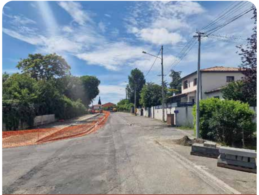
Les travaux en cours chemin de Bénech.
